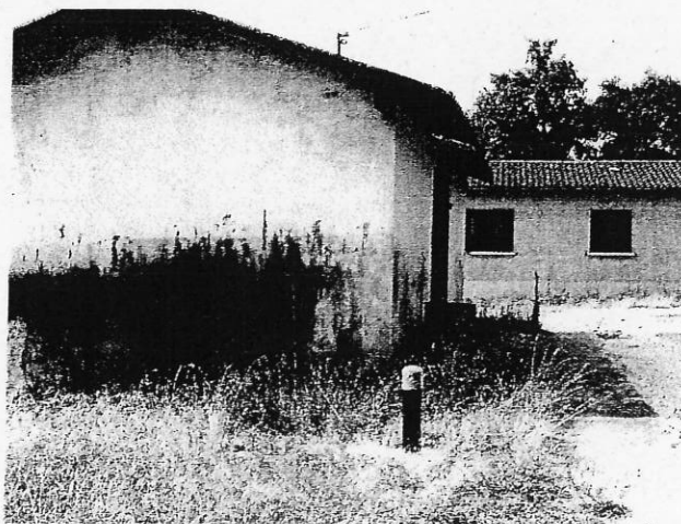
Figure n°6 Tête métallique cadenassée sur PZ2
