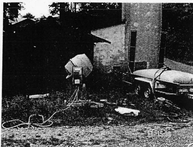
Figure n°1 : Système d'injection du coulis bentonitique (GTEC.03.043.TER.AF(CO.014.1)001.1)
